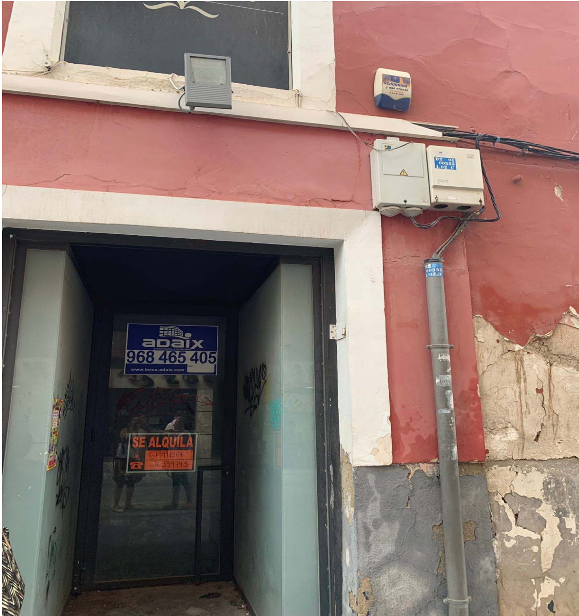
Local cerrado que no mantiene condiciones mínimas de ornato.
